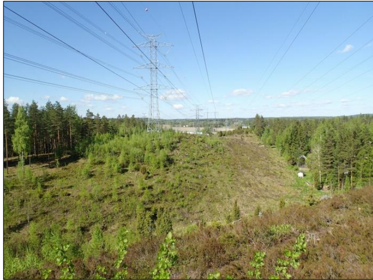
Linjan länsipää Hikiän sähköaseman itäpuolella. Länteen.
